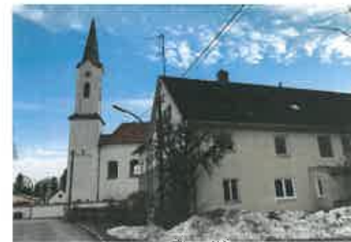
Rückfassade des Chamberger Hauses
